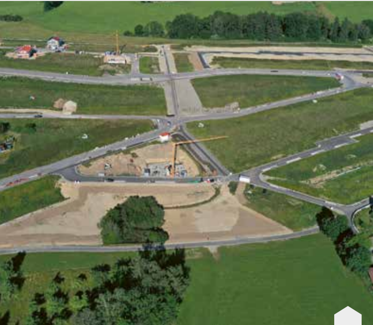
Bebauung in Kempten, „Daheim Auf der Halde“
