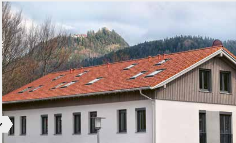
Bebauung in Pfronten, Meilinger Straße
